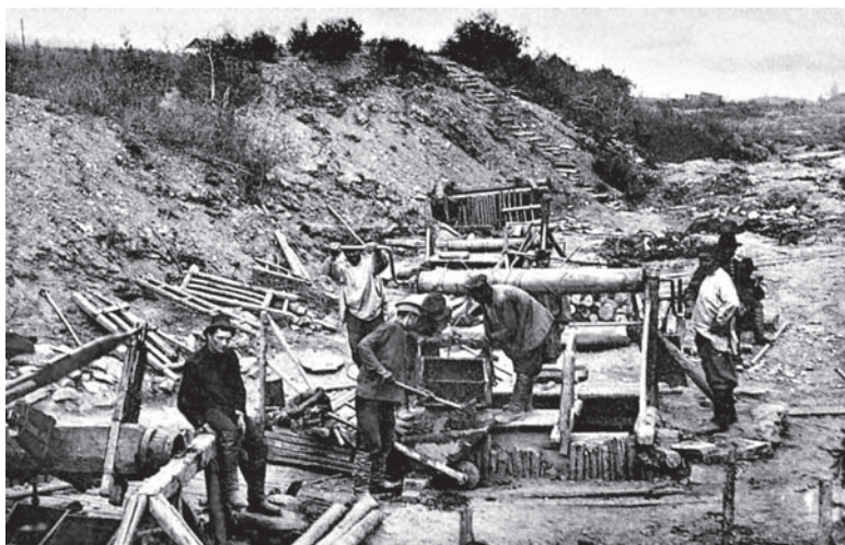
Maata nostetaan vinssillä ikiroutaan kaivetusta maanalaisesta kaivannosta.
