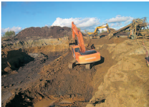
Kulta Prospektorin hyvin järjestetty konetyömaa Puskun latvoilla. Työkoneina Daewoo ja Komatsu, bihnakuljettimet antavat lisää ulottuvuutta. Eri maakerrokset erottuvat selkeästi kuvan vasemmassa laidassa. Kuva: Sirkka Merenluoto.
